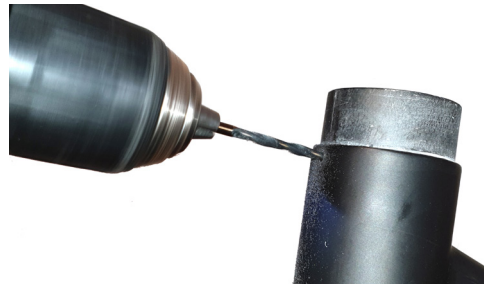
Abb.: Bohren des Lochs für die Stromversorgung
